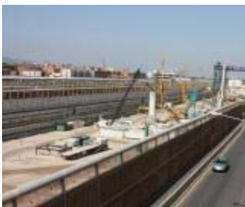
Scavi stazione AV a Bologna
