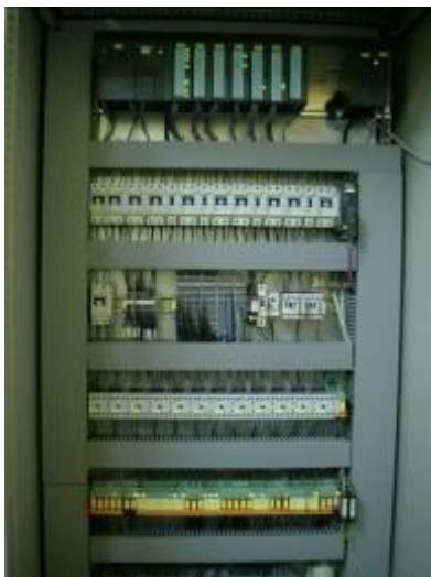
Kontrol- kaj komandoĉelo, transformilo por 110 kV (Chitila)
