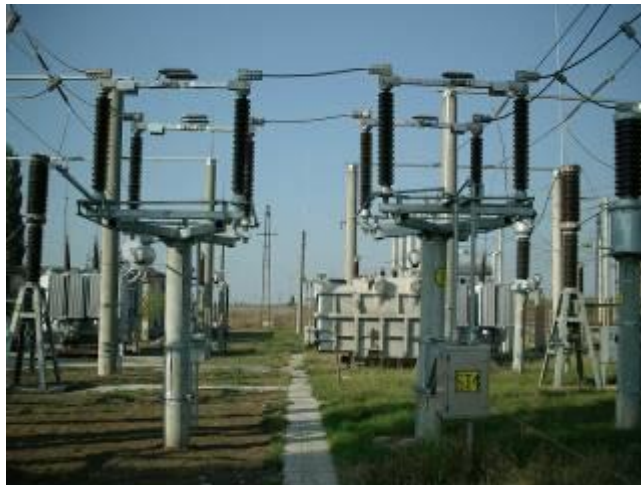
Transformĉelo por 110 kV (Chitila)
