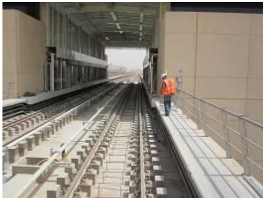
La du trakoj kaj la du flankaj pasaĝerkajoj de unu el la haltejoj.
