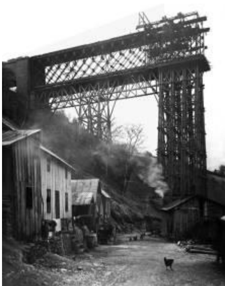
Konstruo de la pilieroj. Malantaŭ sur la vojo staras barakoj, kie loĝis la laboristoj.
