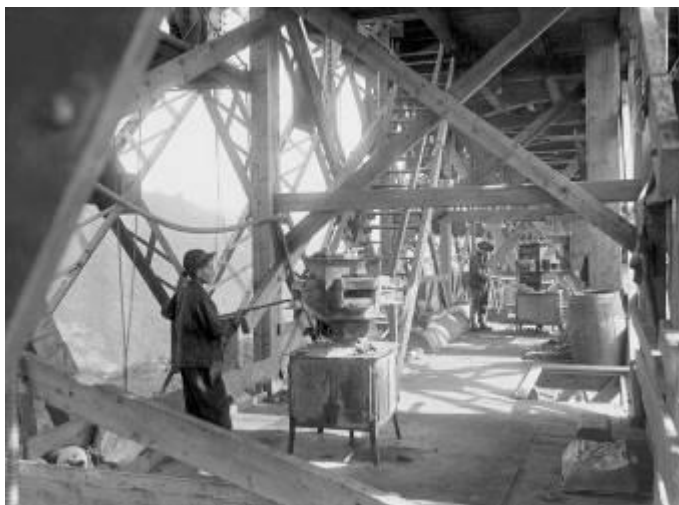
Du junuloj varmigas nitojn en speciala forno.
