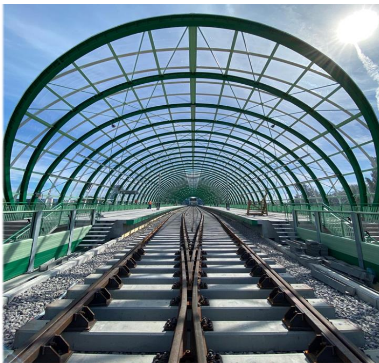
Fig. 2: Disforkiĝo sur la nova fervojlinio (S.C. I.S.P.C.F. SA)
