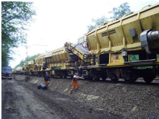
Vagongrupo transportanta la superfluan grundon
