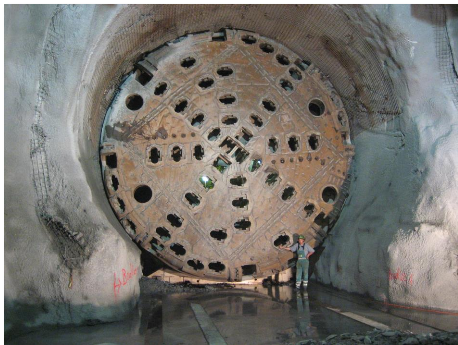
Tunelbormaŝino dismontata en la tunela stacio Faido (bildo: Cooper.ch, CC-BY-SA, Wikimedia)
